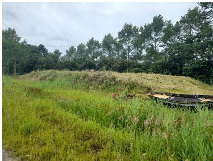
Foto 9 – Gronddepot zuidelijke terreindelen
