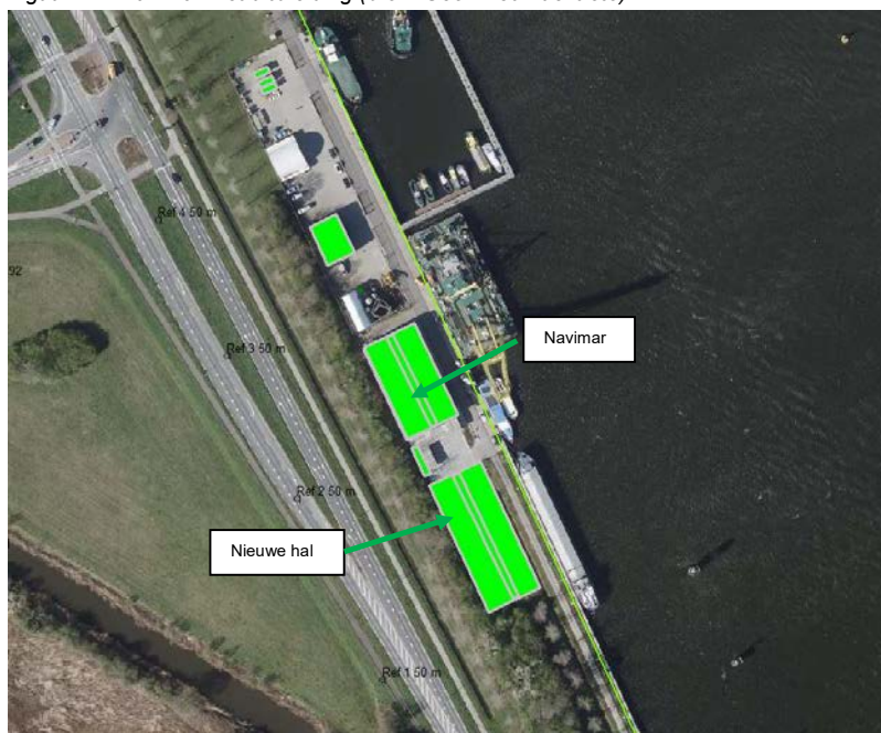
Figuur 2.2: Navimar met uitbreiding (bron: Geomilieu+luchtfoto)
