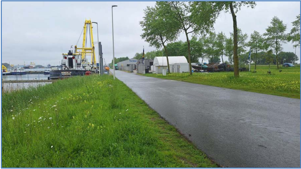
Toegangsweg naar het Bedrijventerrein Goessekade vanaf het sluiscomplex. De ecologisch waardevolle graslandjes en oeverzone blijven in stand.
