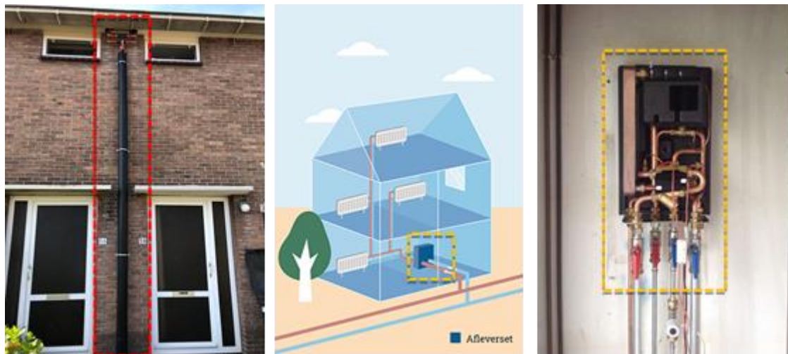
Afbeelding I.8 Aansluitleiding langs de gevel en afleverset
